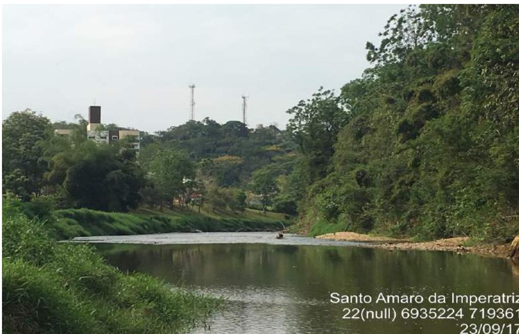
**Foto 5: Vista geral de ambas as margens onde receberá tratamento com enrocamento, mas este trecho também passará pelo processo de desassoreamento do leito do rio, como se vê pela margem direita as ilhas de deposição de seixos rolados.**
