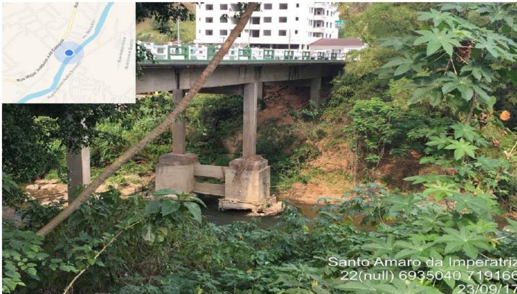
**Foto 2: Vista geral do encontro de ponte da margem direita onde receberá uma camada de enrocamento junto ao talude para proteção contra erosão e solapamentos. Com 1,00 m de espessura e 3,00 m de altura junto ao talude em solo.**
