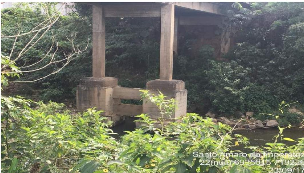
**Foto 3: Vista geral do encontro de ponte da margem direita onde receberá uma camada de enrocamento junto ao talude para proteção contra erosão e solapamentos. Com 1,00 m de espessura e 3,00 m de altura junto ao talude em solo.**
