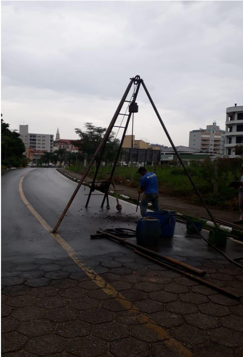
FOTO 01: (SP01)- Furo de Sondagem realizado conforme a NBR 6484
