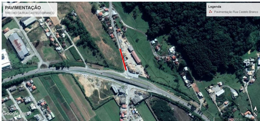
Figura 1 - Local à ser pavimentado com concreto betuminoso usinado à quente CBUQ. Fonte: Google Earth.
